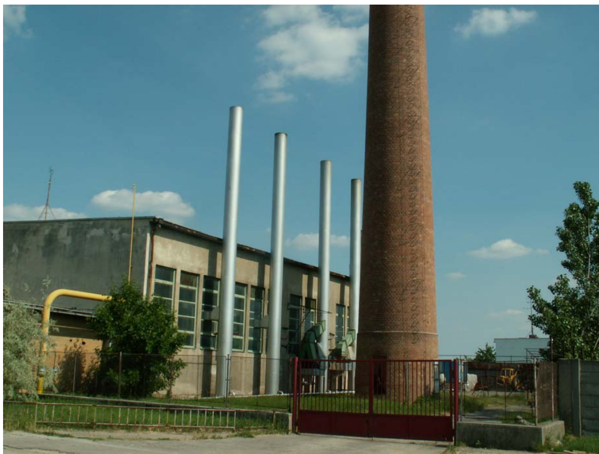
Obr. č. 3 : Kotolňa CK 32 po zrealizovaní prepoja CK 31 a CK 32 bude odstavená z prevádzky
